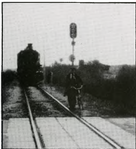
10 Alla sätt är bra. Stopp i infarten till Storlien. Inget svar i telefonen. Lokföraren tar cykeln in till stationen för att meddela: "Vi är här nu"! Foto 85 06 18.
