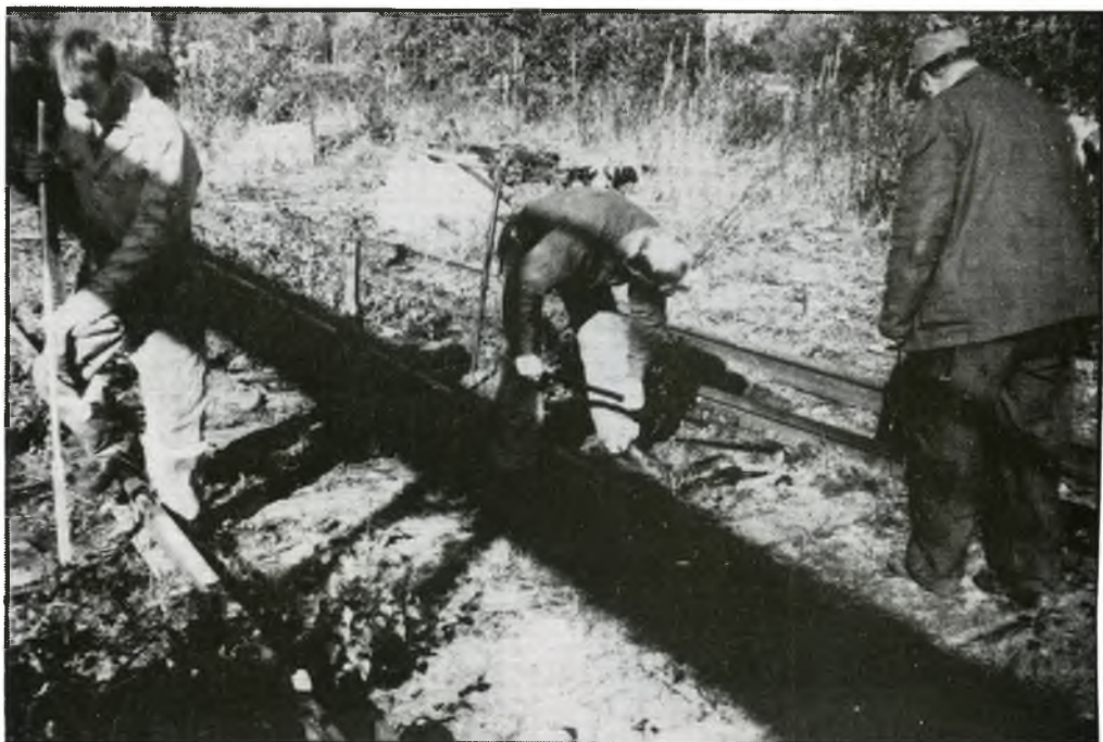
Reparation av den trasiga växeln i Svartvik.
