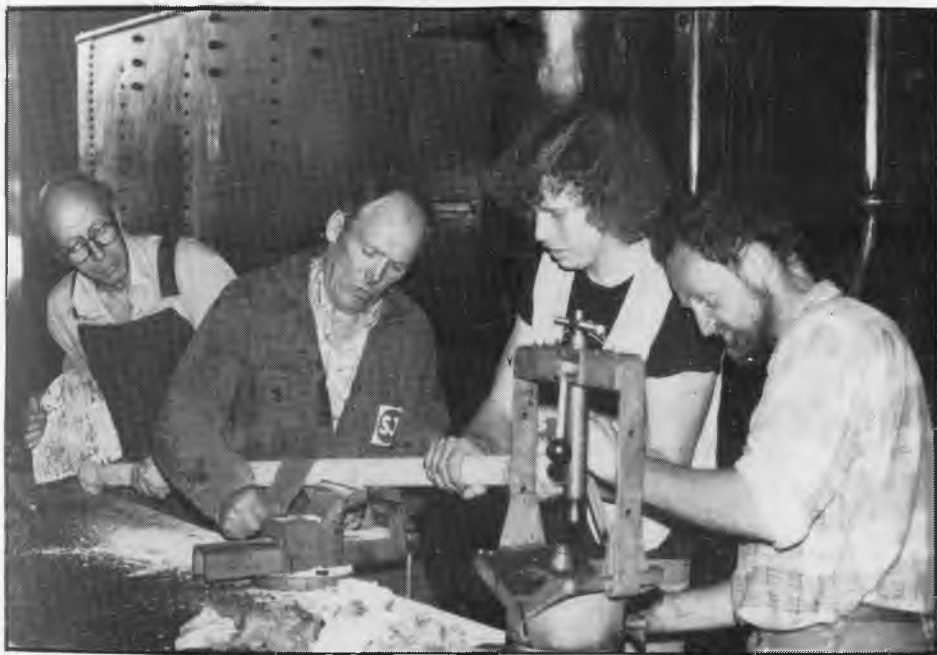
En unik skapelse ser dagens ljus — i stället för att gå upp på tendern och lämpa kol kan man nu göra detta inifrån hytten via koltåget med detta "gräv". Tillverkare: Arne Brunman, Bengt O Hågström, Leif Andersson, Gotthard Tingström.
