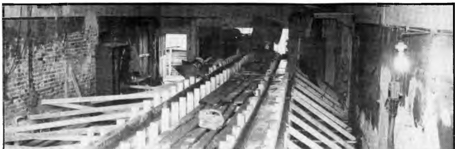
Svartvik 81-09-14. Betongpumpbilen har just farit iväg efter avslutat värv. 16,5 m 3 gick det åt till smörjgravsväggarna. Foto: R Stén.
