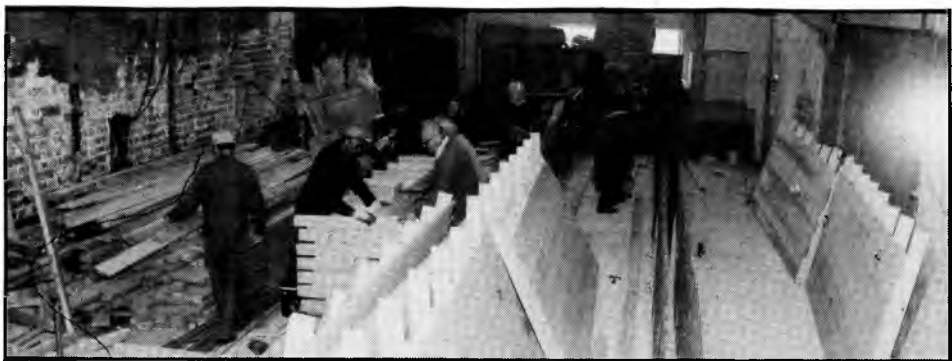
81-08-29 arbetslördag i Svartvik. Det är full fart på formsättningen. Foto: R Stén.
