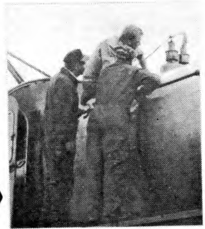
Statens Anläggningsprovning gör sitt driftprov 1977-05-16. Sven Abrahams-son, SA, Gunnar Wallin och Bengt Dahlberg kollar in säkerhetsventi-lerna.
